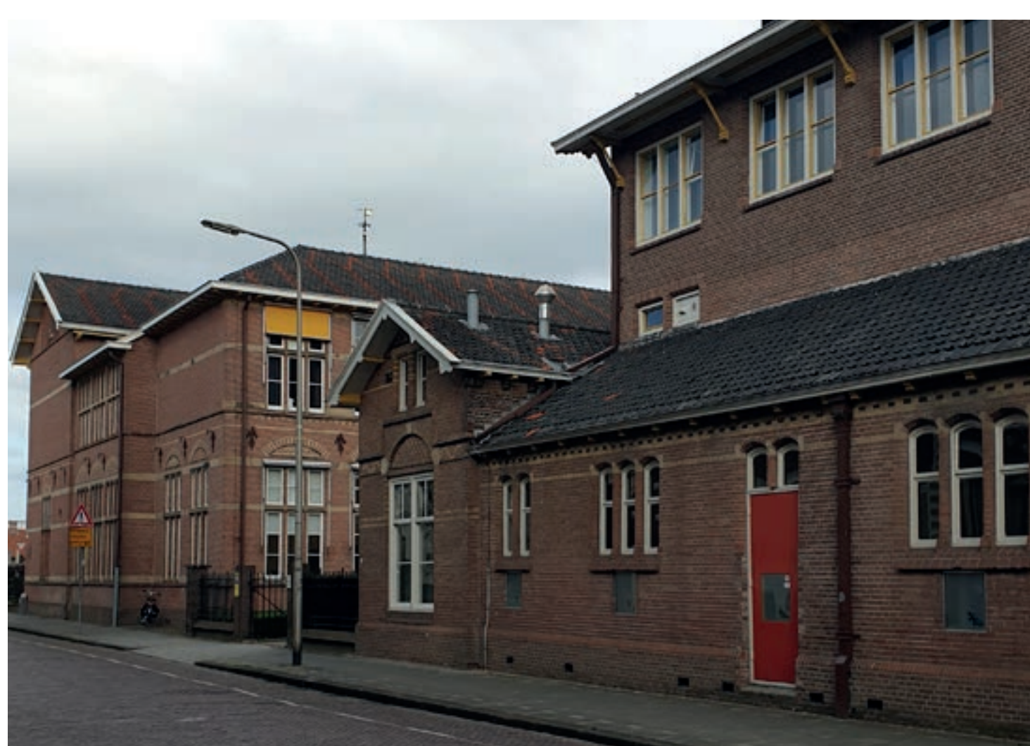
Gymzaal en het entreegebouw.
