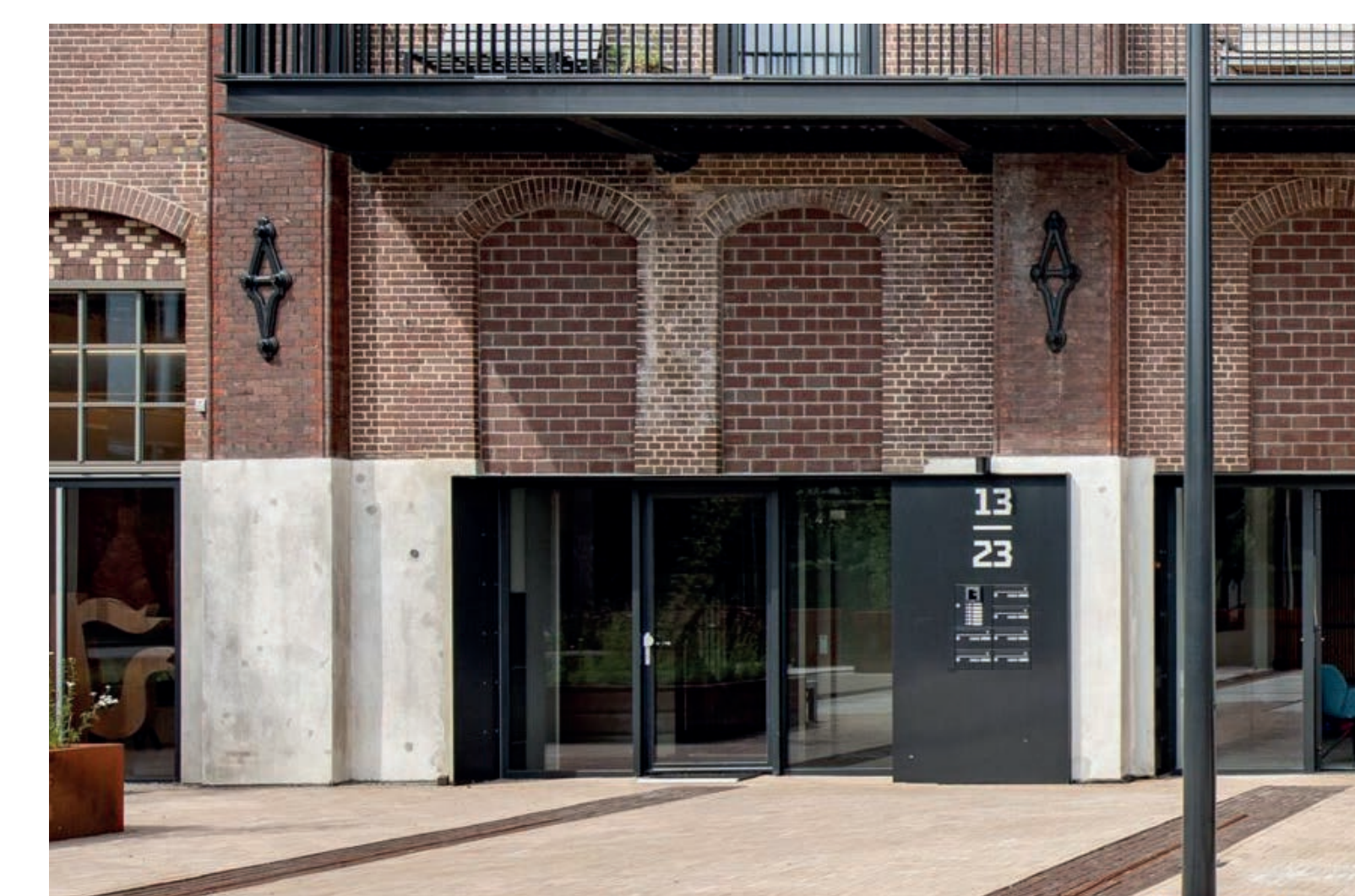
Gymzaal vanuit de binnentuin
