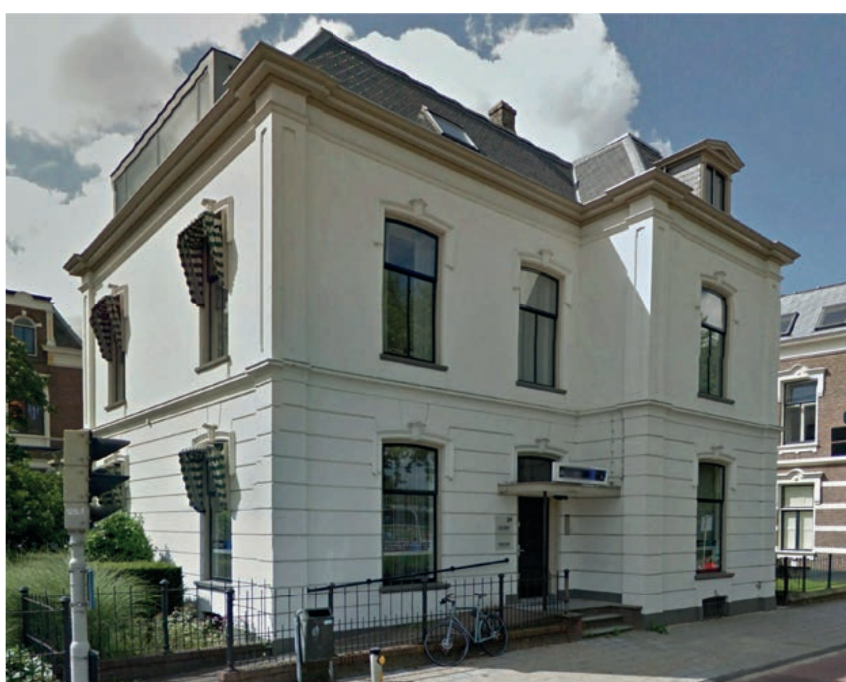
Horizontale geleding en verticaliteit in openingen
